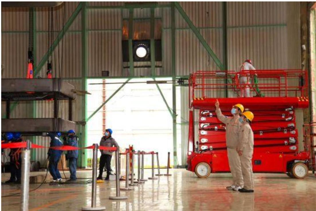
2月15日清晨，上海±500千伏南桥换流站极1阀厅内，一台升降平台车不停地运转着，将全新的阀模块吊至空中，工程作业人员互相配合，紧张地进行着阀塔组装工作。中国首座500千伏直流换流站南桥换流站大规模直流核心设备整体改造正进入攻坚冲刺阶段。
